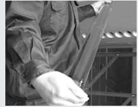
**P10.** Sostener la parte inferior de los tubos para protegerlo al ser colocado en el tanque.
