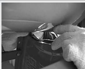
**P7.** Montar el tanque sobre la estructura de soporte y fijarlo con las tuercas.
