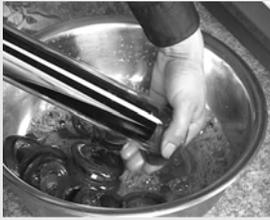
**P8.** Mojar la extremidad superior del tubo en agua con detergente para facilitar la colocación.
