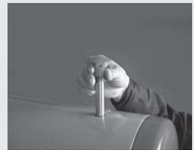
**P16.** Instalar **OBLIGATORIAMENTE** un viente para el sistema.
